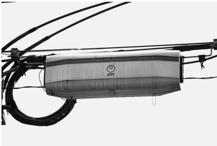
光ファイバー用接続ボックス（クロージャー）
